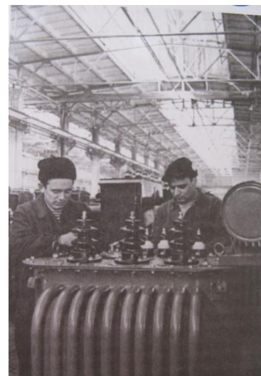
Передовые электрослесари Рыбаков Г. и Матусевич Н. за сборкой масляного трансформатора. 1958 год
