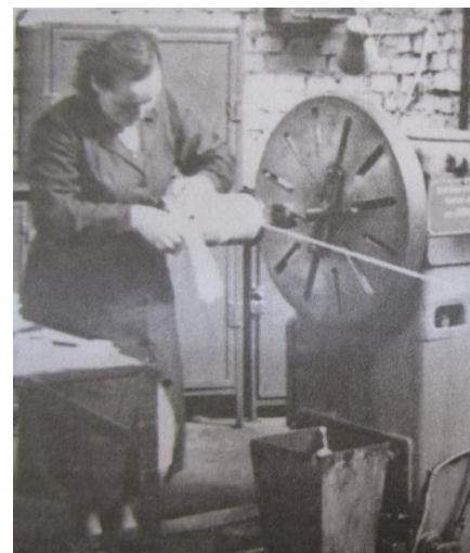
Намотчица Валентина Алай во время изготовления первой обмотки для трансформаторов ТМ-30/10. 1956 год.
